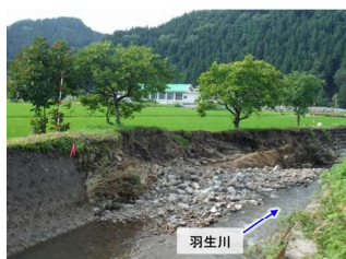
【羽生川(福井市大宮町 等)】 ブロック積護岸等による復旧
