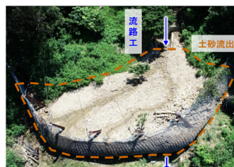
【土砂流出防備保安林(福井市蒲生町)】 土砂流出による被害を防ぐため治山ダムを復旧 大量の土砂を透水型治山ダムにより堰き止め、 民家や国道等の甚大な被害を防止
