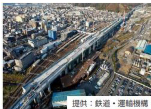
【工事が進む北陸新幹線敦賀駅】
