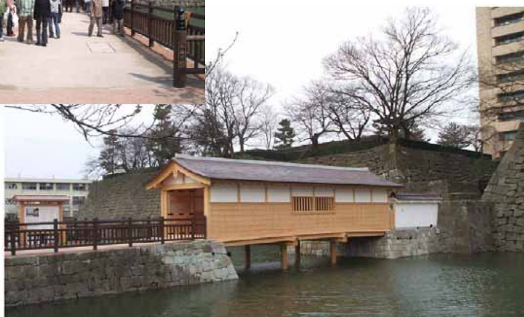
平成 2 0 年 3 月に復元整備された御廊下橋
