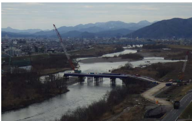
【九頭竜川橋りょう工事】
