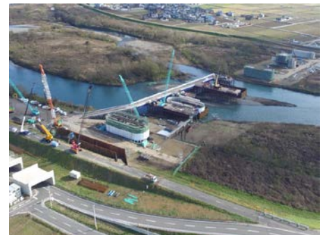
【九頭竜川橋りょうの工事】
