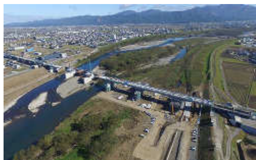
【九頭竜川橋りょう工事】
