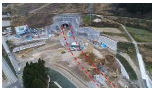
【荒島第2トンネル（仮称）付近】
