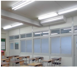
【普通教室の空調設備整備】
