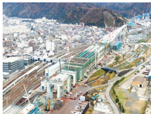
【敦賀駅高架橋】
