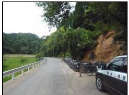
平成30年7月豪雨被災後の状況を確認 (丹生郡越前町山中地籍)
