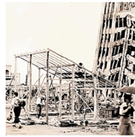
傾いている大和百貨店の周辺で、家屋の再建が進められている=1948年、福井市
