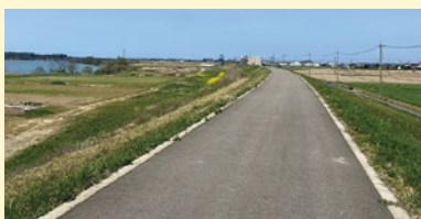
現在の九頭竜川下流と堤防の景色
